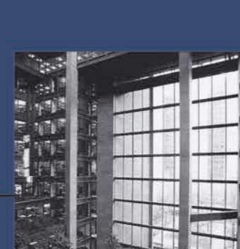
Das abgesenkte Atrium im Wintergarten erschließt den Supermarkt und das Sportzentrum
